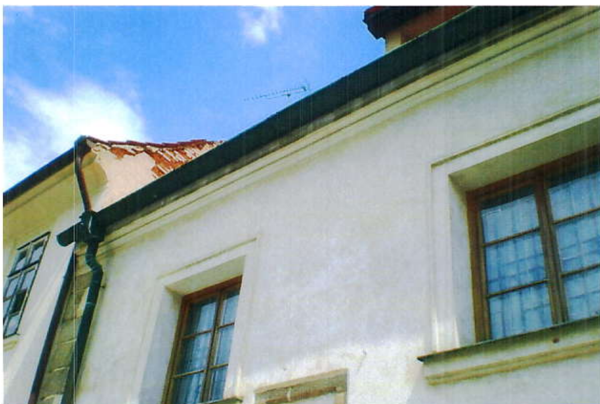
▲ Pohled na část korunní římsy
